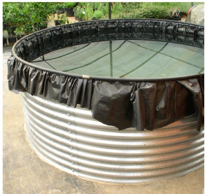
Virole de silo à grain étanchéifiée par de la bâche d'ensilage. Ce modèle fait 2,30 m de diamètre sur 0,90 m de hauteur. Volume utile 3,7m<sup>3</sup>
