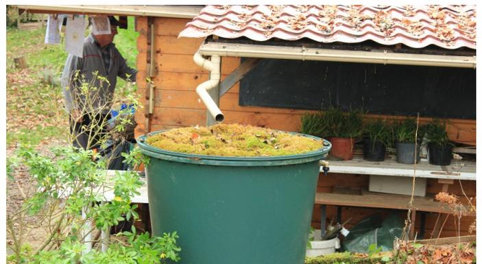
Filtre en tête de citerne le plus simple. Il collecte les eaux d'un toit de 30 m<sup>2</sup> et alimente 4 bidons de 1000 litres chacun.
