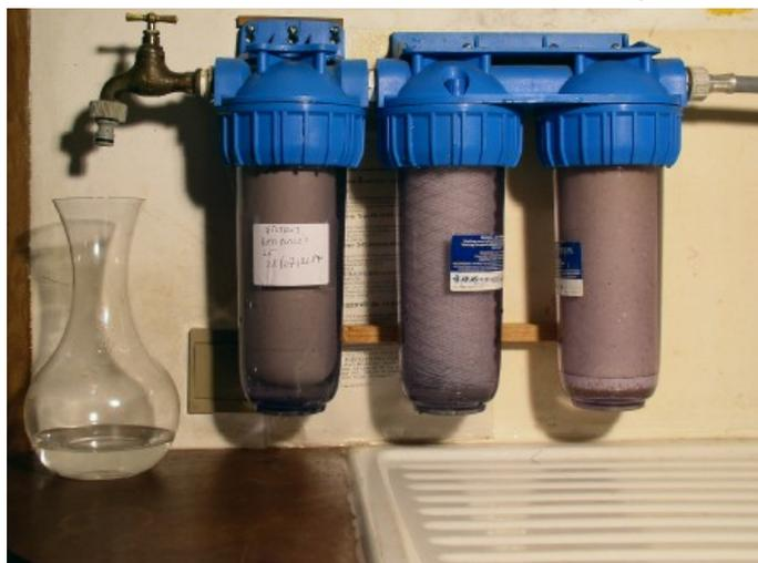
L'ensemble des filtres pour l'eau de boisson, dans l'ordre : charbon, 5 $\mu$ , 0,45 $\mu$ . En amont de ces trois filtre, il y a un filtre général de 25 $\mu$  20 pouces.
