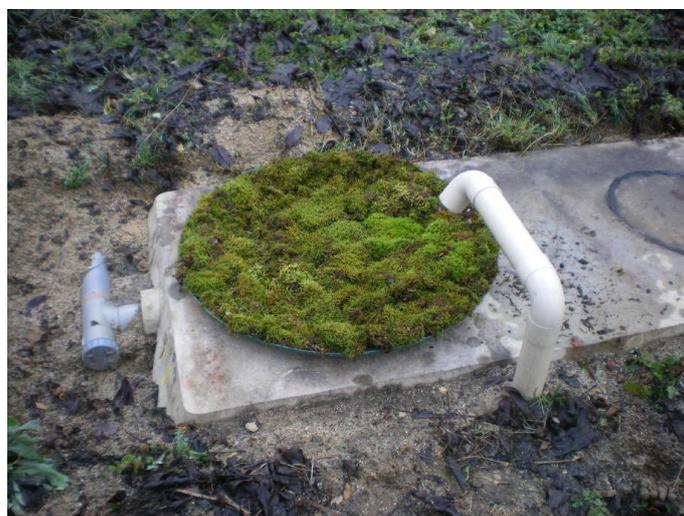
Ici, le filtre est posé directement sur le regard de la citerne en béton. Au lieu d'un couvercle de bidon de 500 litres, vous pouvez utiliser une jolie vasque.
