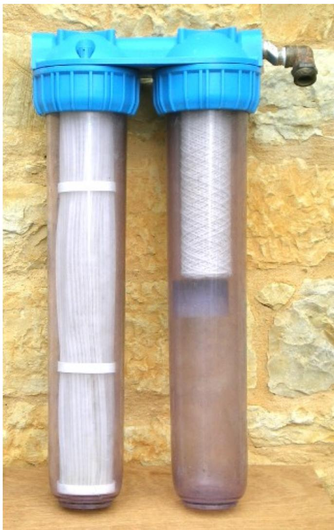
Porte-filtres de 20 pouces avec à gauche un filtre plissé 25  $\mu$  plissé lavable et à droite un filtre bobiné jetable de 5  $\mu$  (10 pouces)
