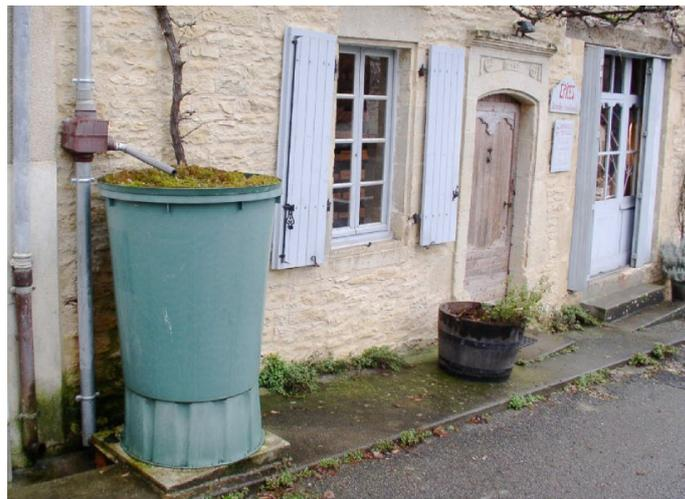
Bidon de 500 litres. Il est préférable de le monter sur un support afin de pouvoir glisser un arrosoir sous le robinet
