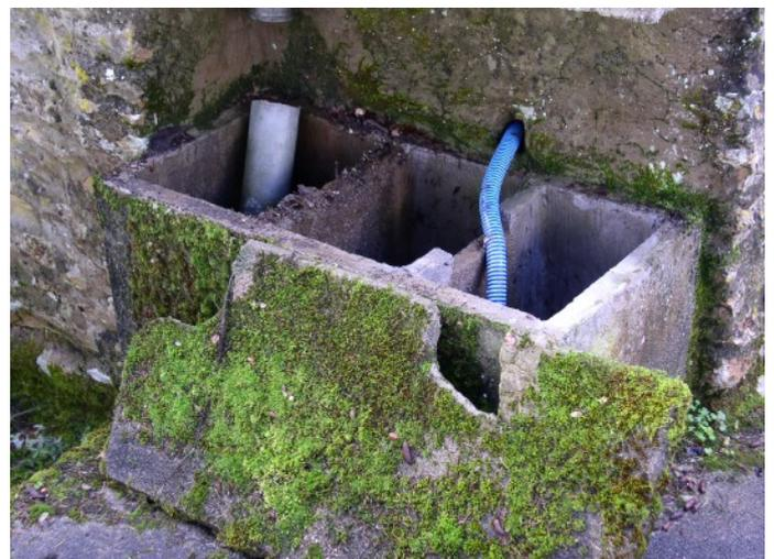
Ce filtre sur une citerne des causses du Quercy comporte un compartiment de gravier, un de sable et un garni de charbon de bois.
